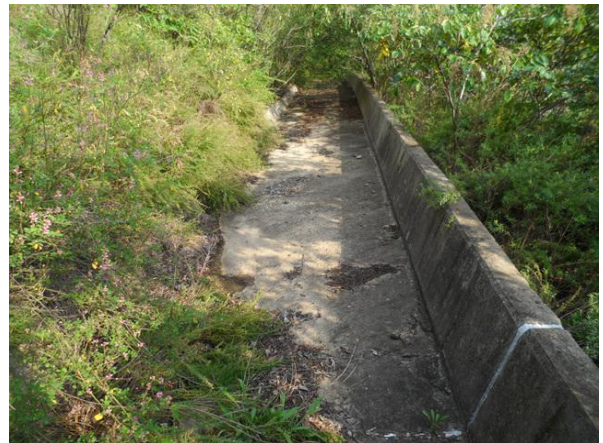
1소단 배수로 전경
