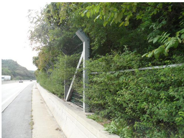
하부, 낙석방지울타리 전경
