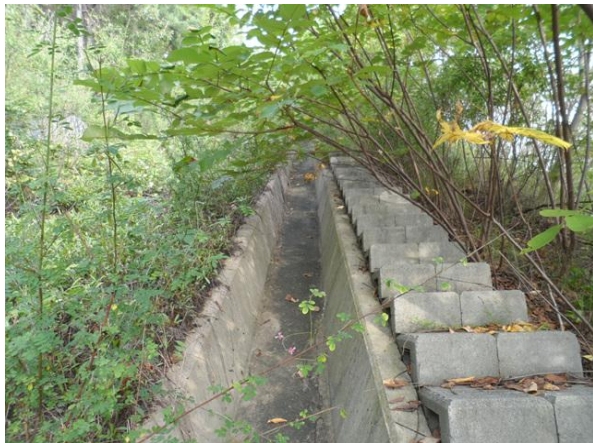
산마루측구, 점검계단 전경
